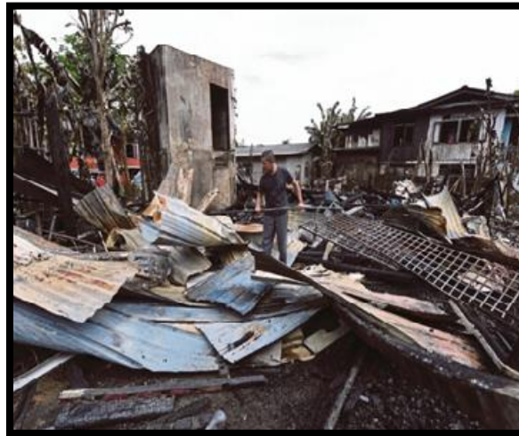
Keratan kabar 1:1; Kes kebakaran Kuala Terengganu
