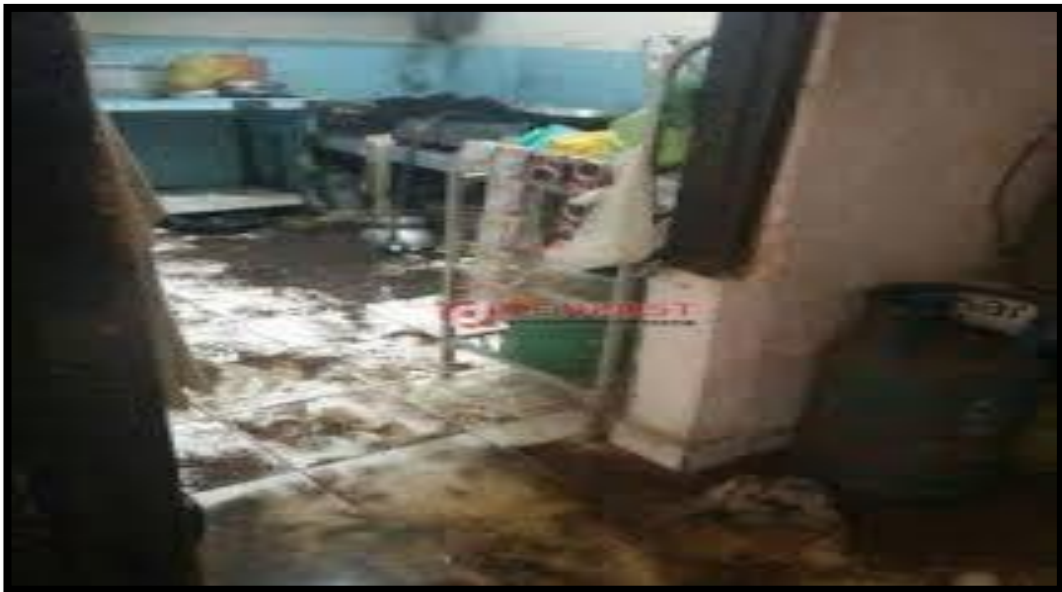
Rajah 2 : kebakaran pada rumah berkos rendah yang berlaku pada 13 NOV 2013 dia sebuah pangsapuri di Shah Alam, Selangor.
