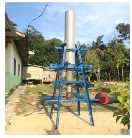
**Gambarajah 2.8: Pemasangan paip PVC pada besi penyokong**
