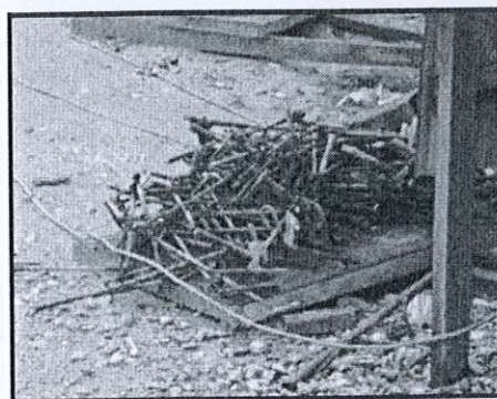
Rajah 2.7 : Longgokan keluli di tapak bina
