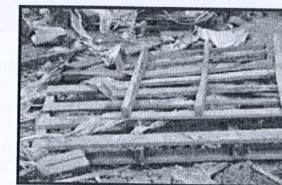
Rajah 2.6 : Sisa Kayu di Tapak Pembinaan
