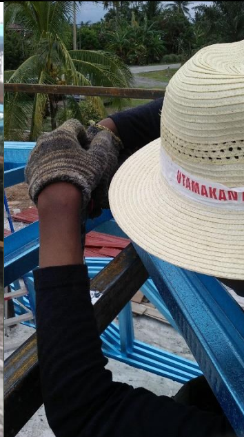
Selepas mendirikan kerangka bumbung/trusses Mula mendirikan Trusses ( jarak antara trusses 1370mm)
