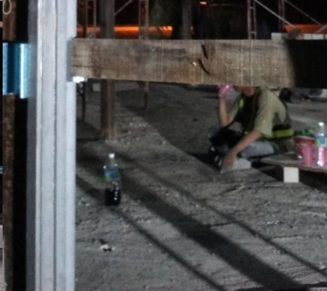
Gambar: Pemasangan bingkai pintu : Perlu kan timbang air bagi memastikan bingkai berada pada kedudukan tegak
