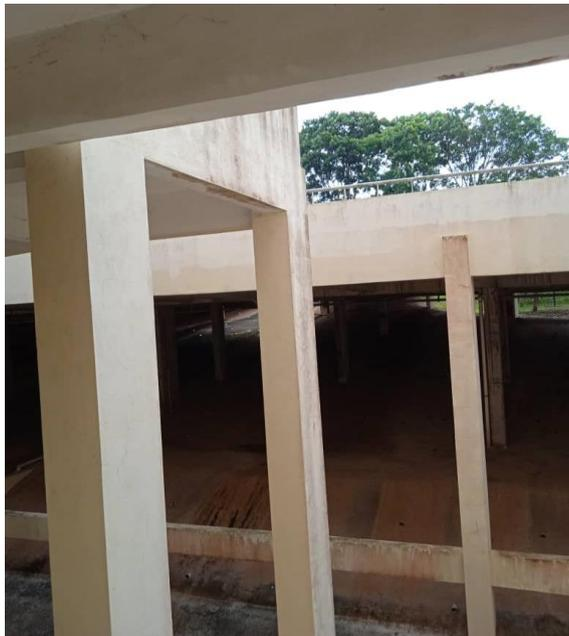
Figure 5.2.1.1 (d) The mold and paint faded
