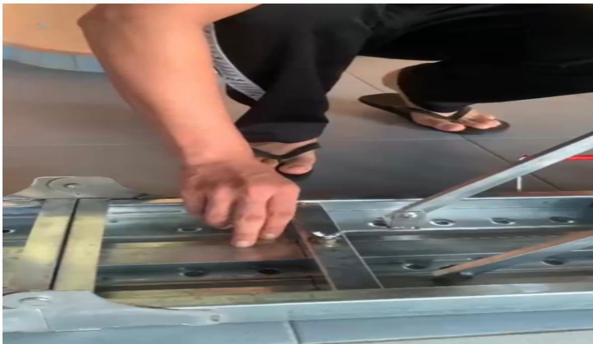
Rajah 4.2.4: Mengikat batang besi
