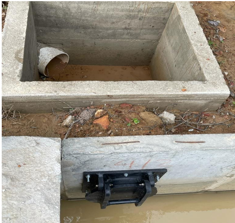
Gambar tersebut merupakan produk Anti-Flood Gate yang telah dipasang di lokasi kajian.
