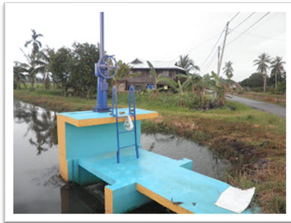
Manual Sluice Gate (Kunci Air/Pintu Air)
