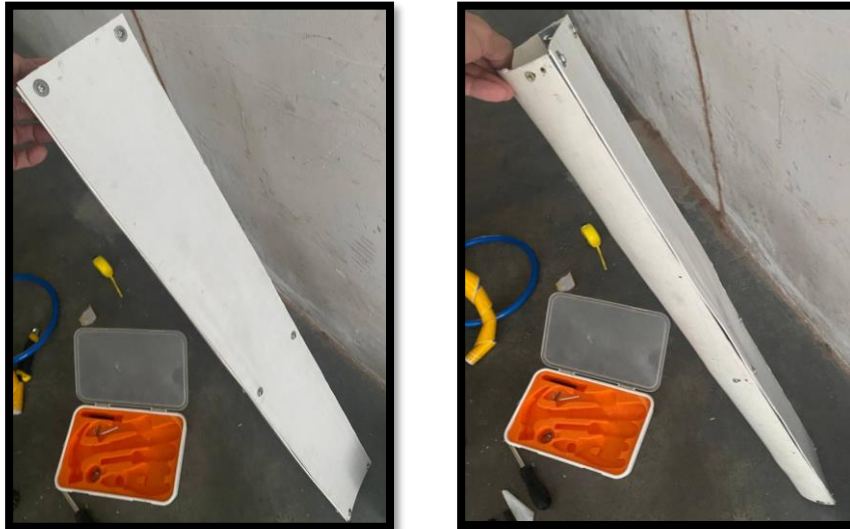
Rajah 3.9 : Proses Pemasangan Antara Paip
