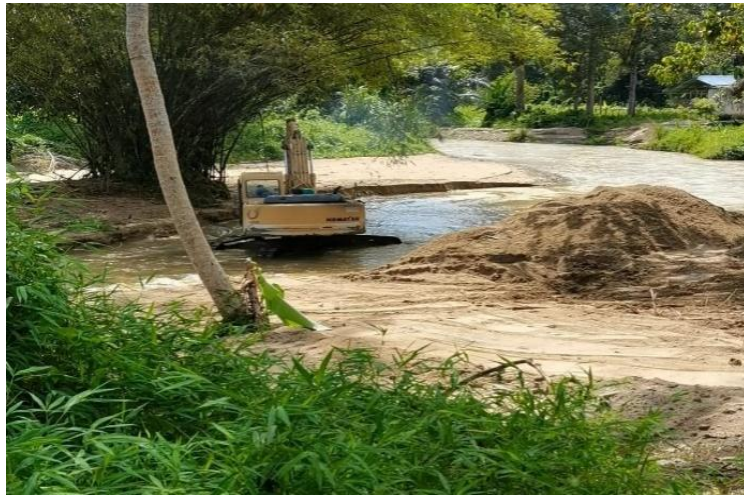
Rajah 4.2.3viii: Kerja-kerja dalamkan sungai dijalankan di Sungai Lui
