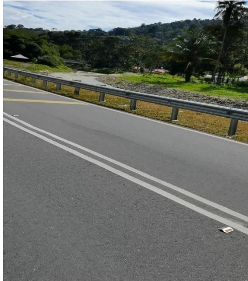
4.2.3.vi . Jalan raya Sungai Lui yang telah dibaiki
