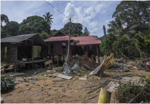
Rajah 1.3 iii. Kerosakan struktur rumah di laluan Batu 18
