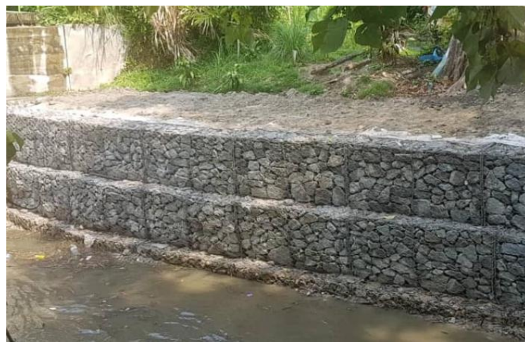
Rajah 2.2.1.iv Gabion Matress
