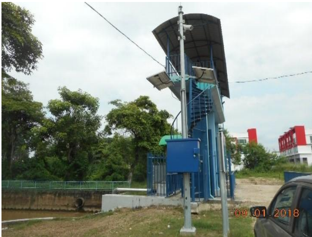
Rajah 4.2.3 iii IP kamera yang digunakan bagi memantau kejadian banjir
