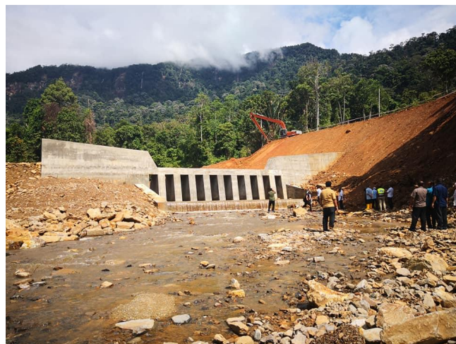
Rajah 4.2.3.iv Empangan Sabo di Yan Kedah
