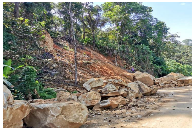
Rajah 1.3vii. Cerun runtuh di permukaan tebing bukit
