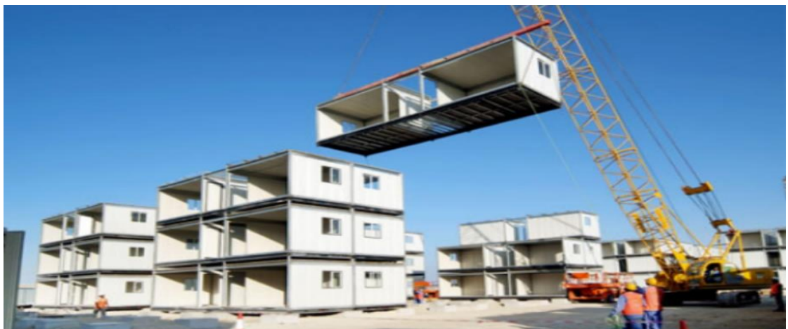
Rajah 2.3: Komponen diangkut dengan kren
