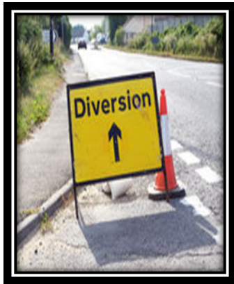
Rajah 4: Penanda sementara sedia ada yang terdiri daripada advance warning sign, kon keselamatan dan triangle warning sign
