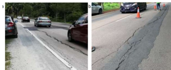
Rajah 1.1 - Rekahan membujur ditemui sepanjang FT005 a) regit b) semerah
