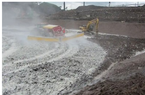
Rajah 1.4: Percampuran simen dan tanah
